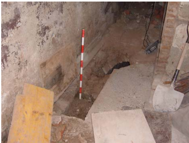
FOTO 15. Vista general mur UE 12 i volta UE 14.
