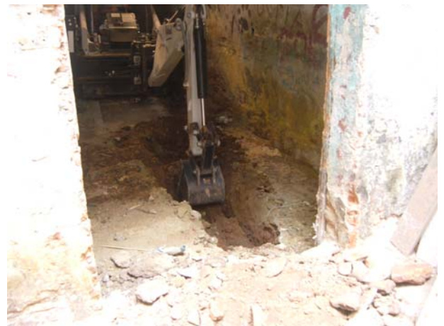
FOTO 8. Realització de la rasa 3.
