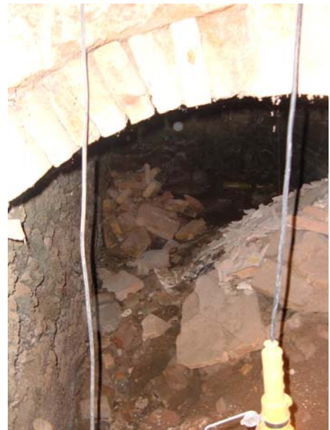
FOTO 16. Vista de l'interior de la galeria.
