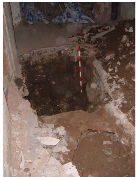
FOTO 4. Vista del fossat d'ascensor o rasa 1.
