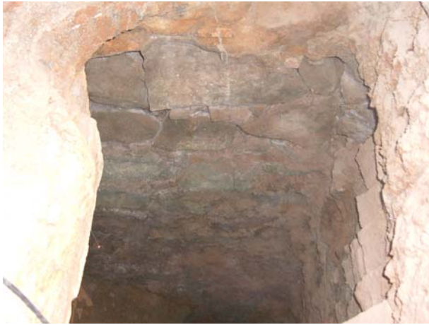
FOTO 13. Vista del mur UE 12.
