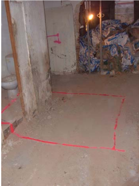
FOTO 1. Vista inicial del' espai on s'havia projectat el fossat d'ascensor.
