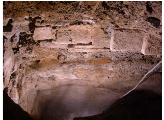
FOTO12. Vista del mur UE 13 i l'arrencament de la volta UE 14.
