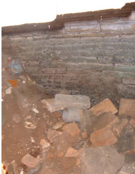
FOTO 11 Vista del mur UE 16..
