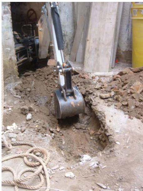
FOTO 7. Realització de la rasa 2.
